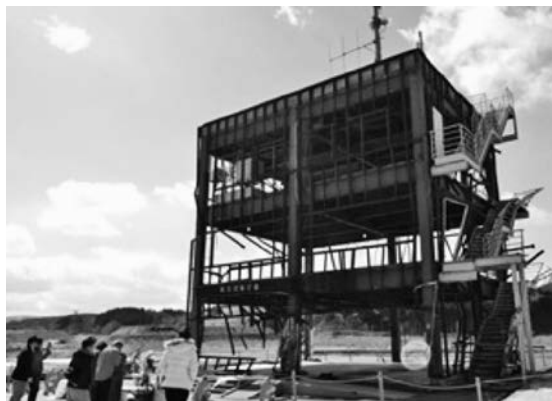
▲ 保存か解体で揺れる南三陸町旧防災庁舎
